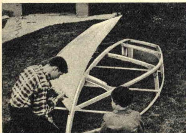
**Fig. 4** - Lo scheletro va ricoperto nel fondo e ai fianchi con legno compensato di ottima qualità che risulti resistente all'umidità. Non riuscendo ad incurvare meccanicamente il legno si ricorgerà all'incurvatura a fuoco.
